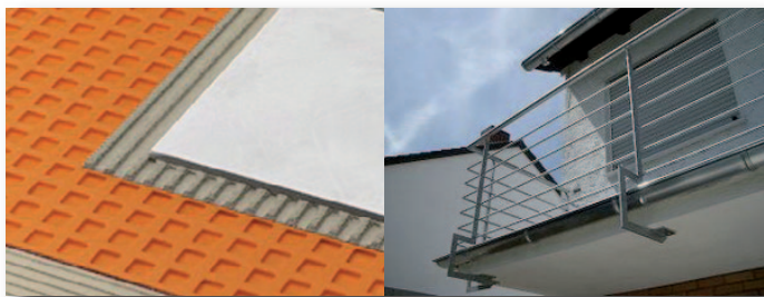
Links: Bodenaufbau mit Dira-Matte als Untergrund, rechts der fertig sanierte Balkon. (Foto: Väth)
