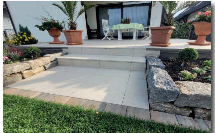
Die großen und rutschfesten Platten auf Stelzlager besitzen wartungsfreie Fugen sind leicht zu reinigen.
