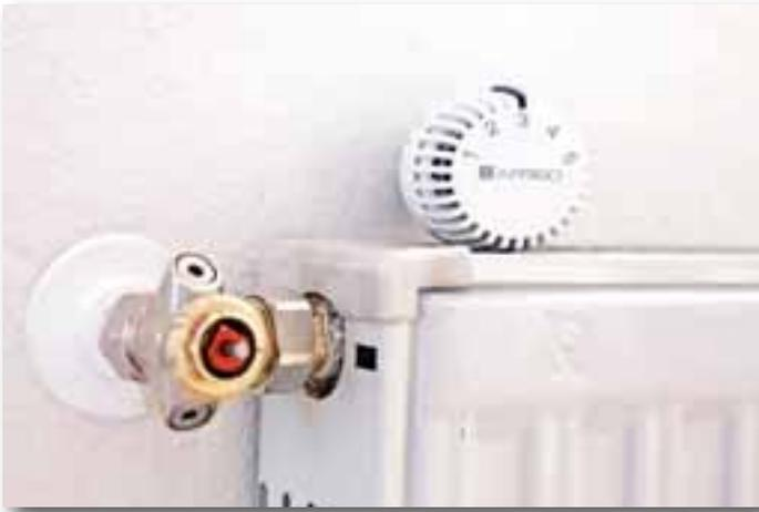
**Voreinstellbare, dynamische Thermostatventile erleichtern den hydraulischen Abgleich.**
