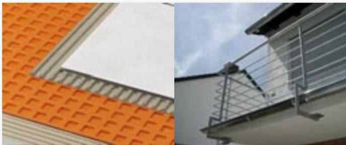
Links: Bodenaufbau mit Dira-Matte als Untergrund, rechts der fertig sanierte Balkon.
